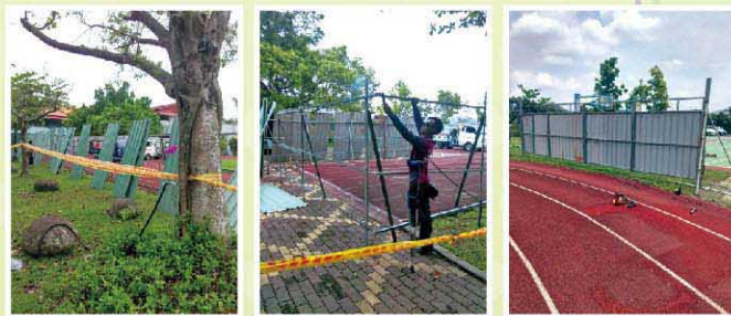
PU跑道整修工程：架設施工圍籬
